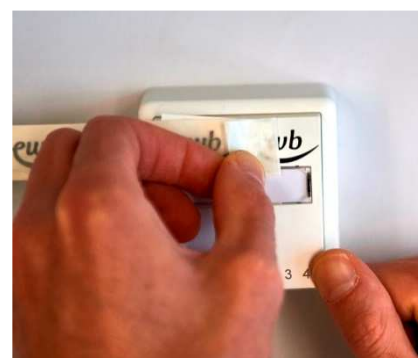
Abbildung 74 Schritt 2, Abziehen der Trägerfolie
