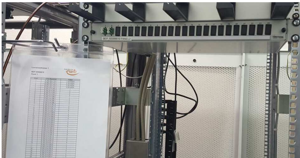
Abbildung 84 Beschriftung BEP 19"-Panel inkl. Legende
