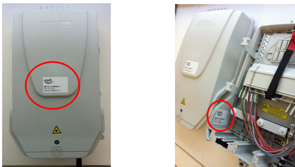
Abbildung 82 BEP inkl. Beschriftung (Li: Aussendeckel; Re: innerhalb des BEP-Gehäuses)
