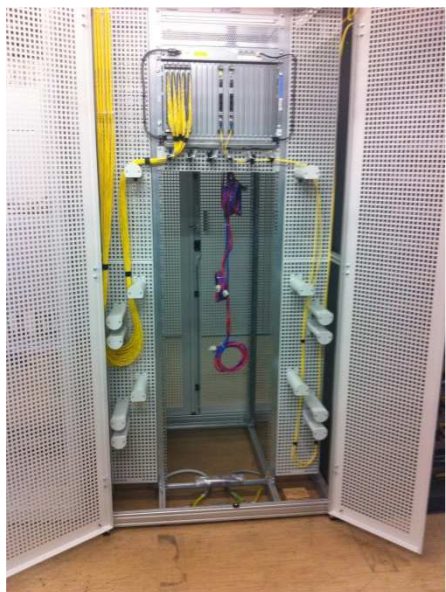
Abbildung 67 Zweites neues Rack mit Milegate Equipment im CO BUE
