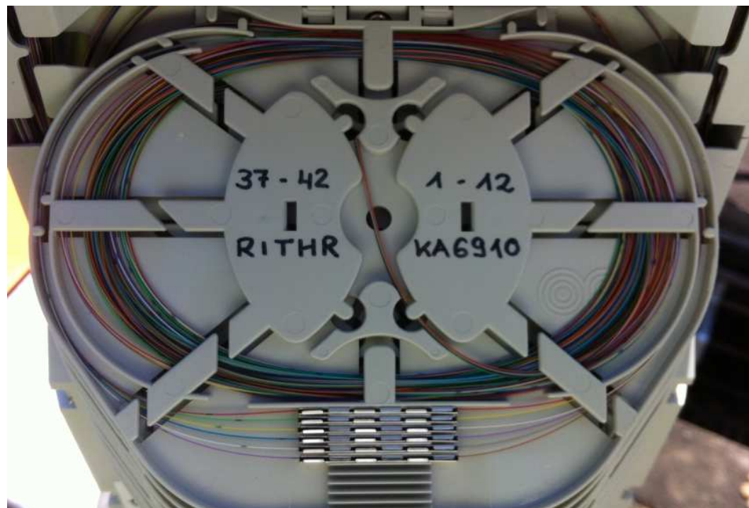
Abbildung 119 Reihenfolge Spleissungen in Kassette
