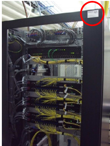
Abbildung 92 ewb Rack inkl. Beschriftungsetikette
