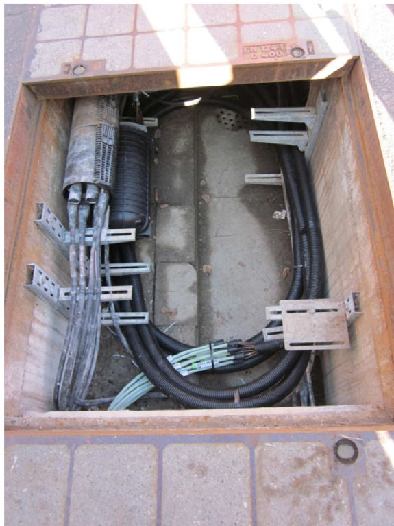
Abbildung 114 Beispiel einer Verlegung in einem Swisscom-Schacht
