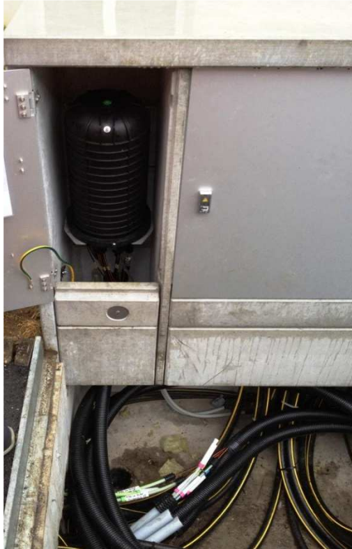
Abbildung 44 FTTH-Kabel in VK-Vorschacht in separatem Kabelschutzrohr
