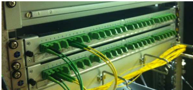
Abbildung 18 Kabelendverschluss KEV
