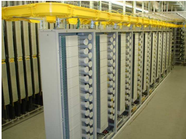
Abbildung 58 OMDF und XMDF im CO (ULL Raum)
