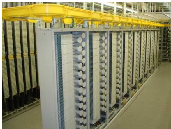
Abbildung 89 OMDF und XMDF im CO
