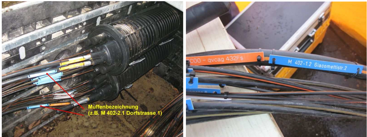
Abbildung 87 Muffenbeschriftung
