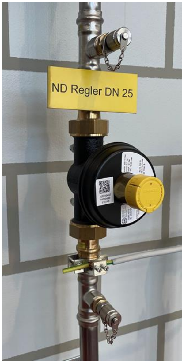
Niederdruckregler mit optionalem Prüfstutzen
