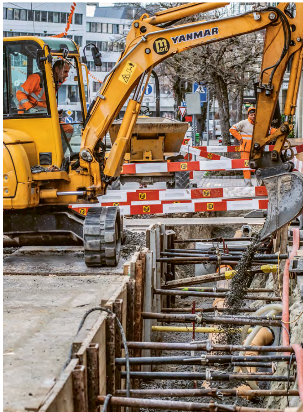
Bild 2 und 3: Werkleitungssanierungen im «höien Breitsch».
