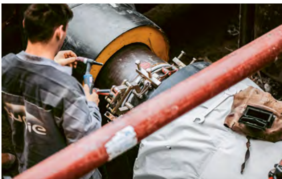
Fernwärme-Rohre werden zusammengeschweisst.
