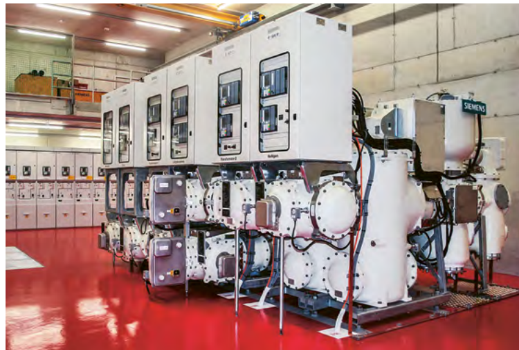
Bild 1: Das neu sanierte Unterwerk Engehalde.
