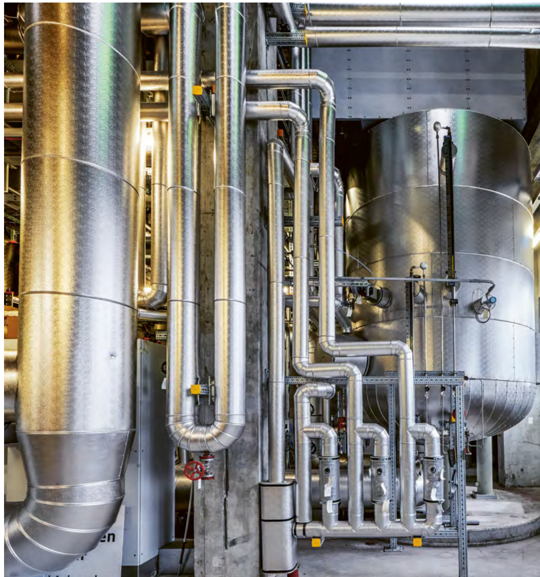
Bild 1: Der Elektrodendampfkessel trägt zur Netzstabilität bei.
