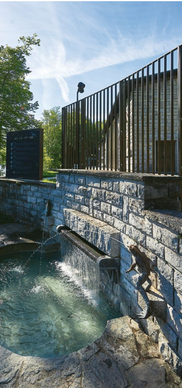
Täglich fliessen 30 bis 90 Millionen Liter Wasser aus dem Aaretal durch das Pumpwerk Schönau in das Verteilnetz von Energie Wasser Bern.
