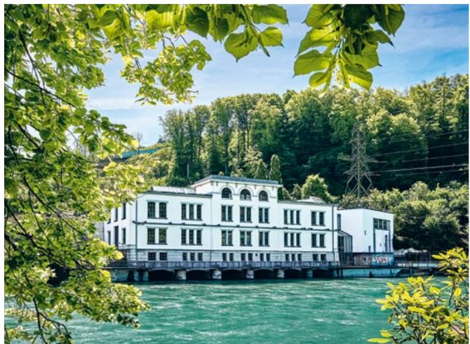
Das Kraftwerk Felsenau nutzt ein Gefälle von 14 Metern, über das maximal 100'000 Liter Aarewasser pro Sekunde fließen. Damit produziert die Anlage rund 70 Gigawattstunden (GWh) Strom pro Jahr, was den durchschnittlichen Bedarf von 15'500 Haushaltungen deckt. **(krs)**
